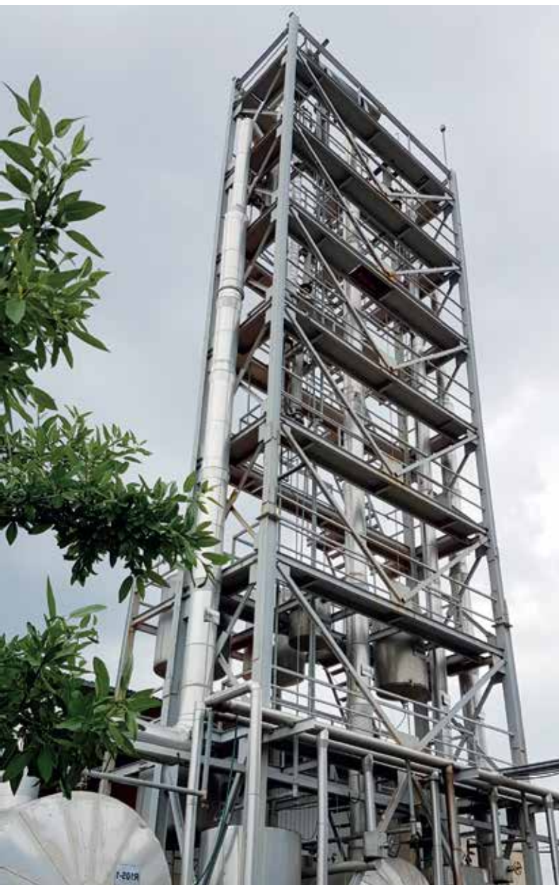
“مجموعه برج های تقطیر مرتفع مستقر در کارخانه اراک”
